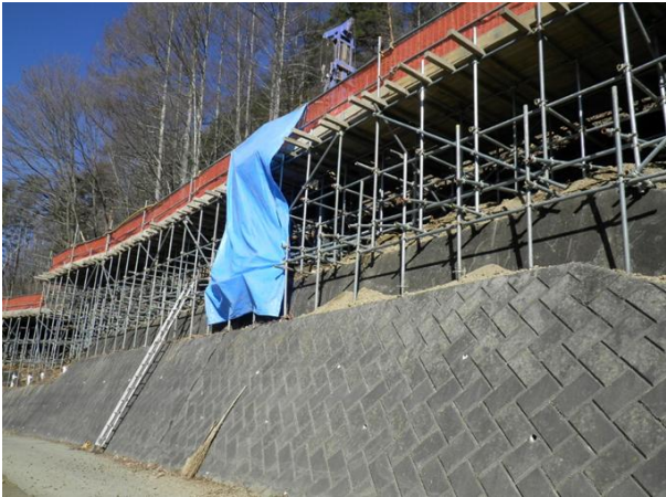
現場での対策（飛散防止ネットの設置）
